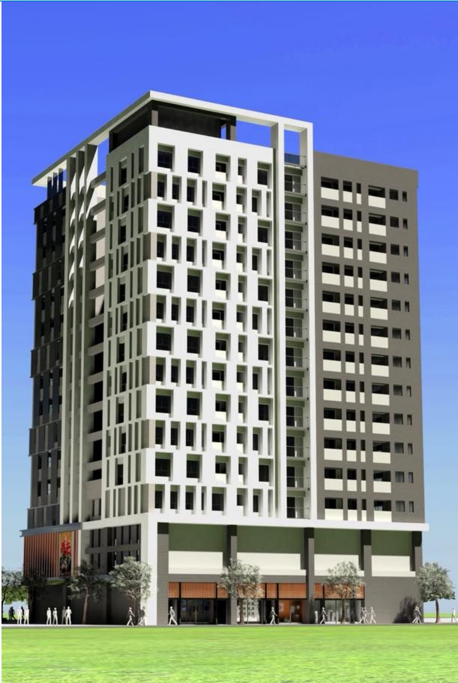
▲中興戲院更新後成為地下2層、地上14層之住商大樓，是我國離島地區都更成功的第一案。(圖/澎湖縣政府提供)
